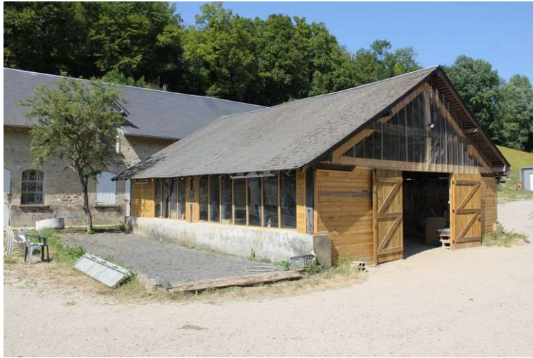
Nouvelle légumerie dans la halle de la ferme
